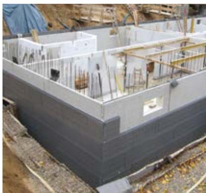
Fig. 03 - Isolamento di pareti controterra
